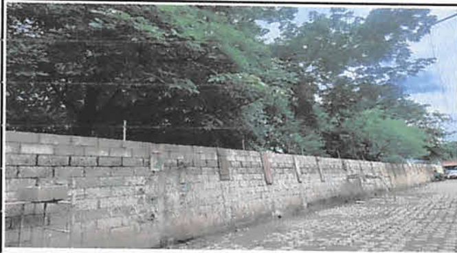
FOTO 3: se levantará y se reforzará el muro perimetral
