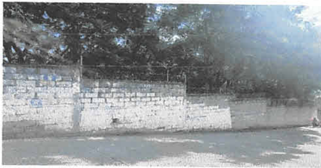
FOTO 5: SE COLOCARÁ ALAMBRE RIZOR EN TODO EL MURO PERIMETRAL
