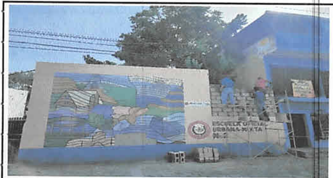
FOTO 6: SE LEVANTARÁ TAPIAL DE FRENTE
